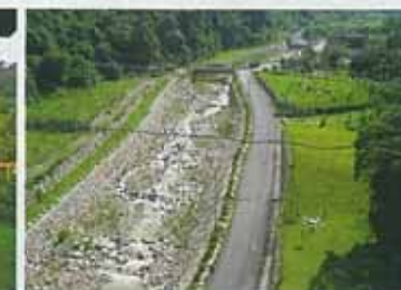
住民参加で作った多自然護岸工法での河川改修
