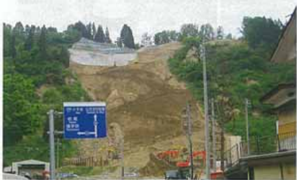
H18.6 崩落法面の復旧状況
